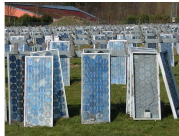
Figure 97 : Panneaux photovoltaïques en fin de vie (source : Soren, 2015)
